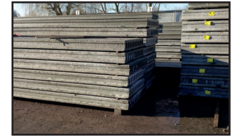
Stockage = - calage sur 10cm des extrémités - sol solide
