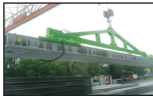
Dalles pleines >6m et <13m = utiliser palanier • Mettre la pince le plus près possible de l'extrémité de la dalle • Max. 1,5m de dépassement
