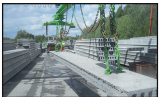
Manipulation pièces finales >6m (VS/SC) = utiliser les chaînes TRA
