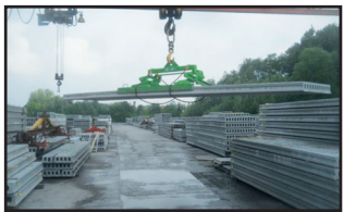
Dalles pleines <6m et poids <2200kg = utiliser pince de 2m
