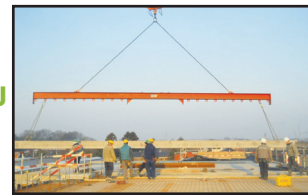
>13m = utiliser le palanier longue distance (avec chaînes TRA)
